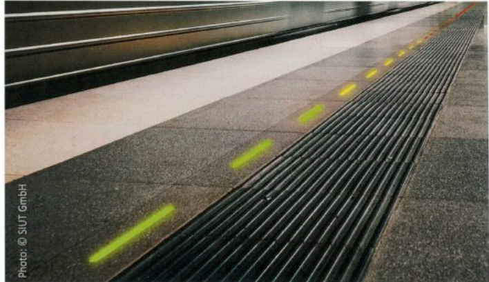
Mögliche Art der Anzeige freier Zugteile: LED-Leitsystem von SIUT mit Farbsignalen (Bild: SIUT GmbH).
