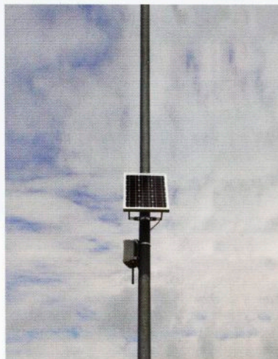
Einige Anker wurden mit Solarpanel ausgestattet, um Verkabelungen im Außenbereich zu vermeiden.
